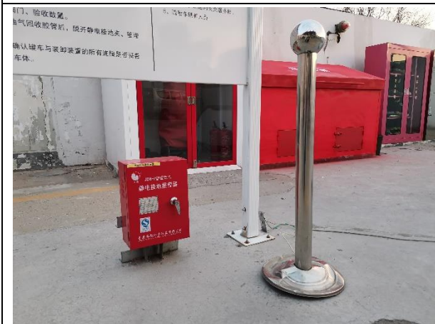
消防设施、静电接地夹、人体静电导除球
