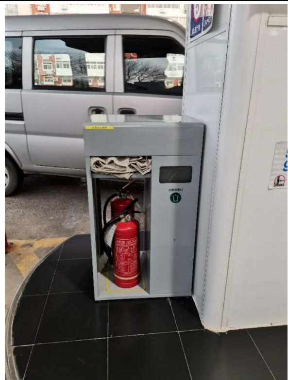
黑塔寺加油机附近消防设施
