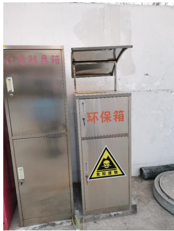
黑塔寺加油站危废暂存设施
