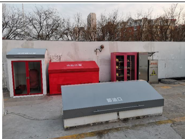
红桥黑塔寺加油站卸油口
