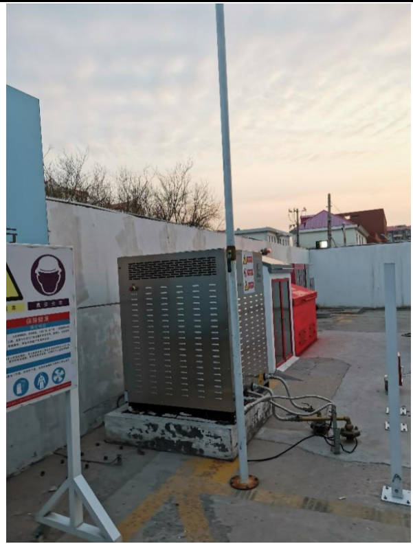
黑塔寺油气排放处理装置
