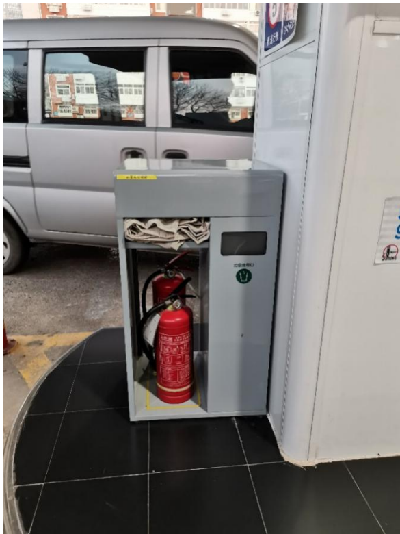
黑塔寺加油机附近消防设施
