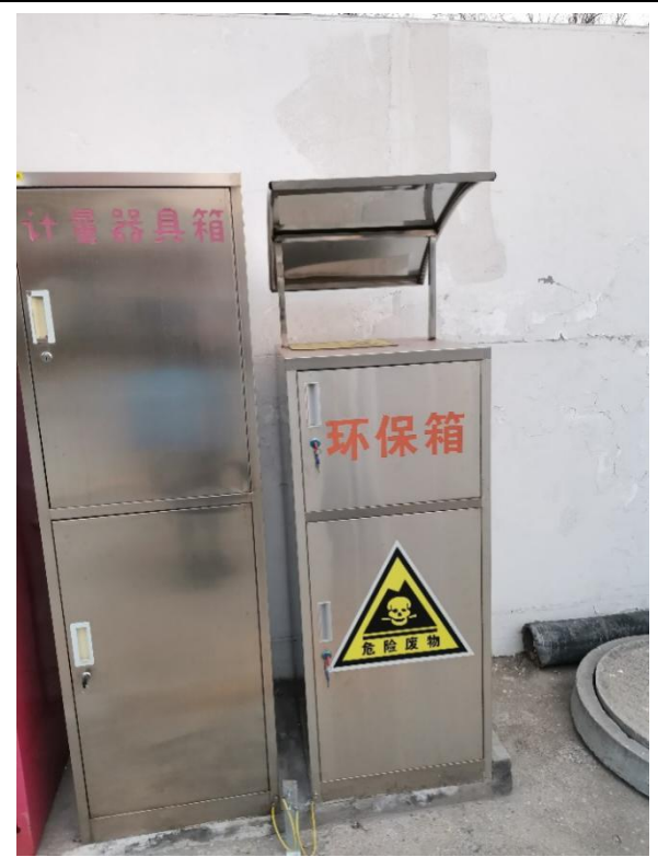
黑塔寺加油站危废暂存设施
