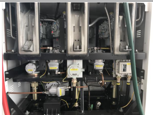
加油机内的真空泵
